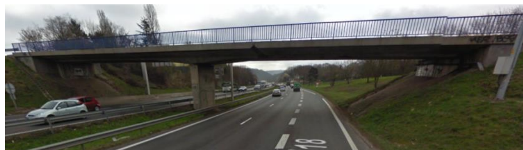
Figure 30. Photo : profil ouvrage existant sur RN118 – source Google Map
