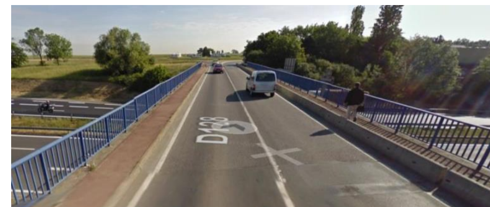
Figure 29. Photo : profil ouvrage existant sur RN118 – source Google Map
